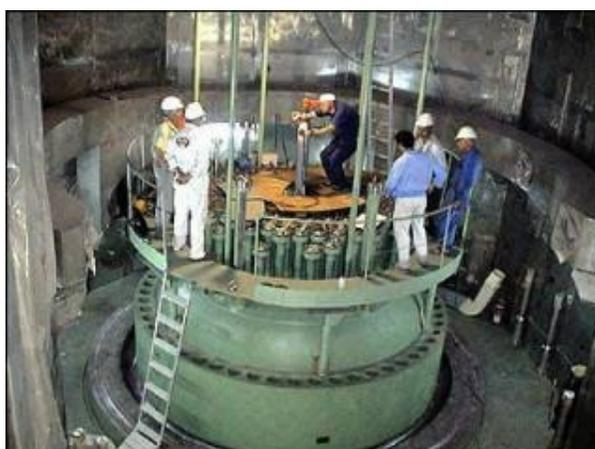
Rys. 3. Montaż rur ochronnych prętów regulacyjnych i bezpieczeństwa na irańskim reaktorze
